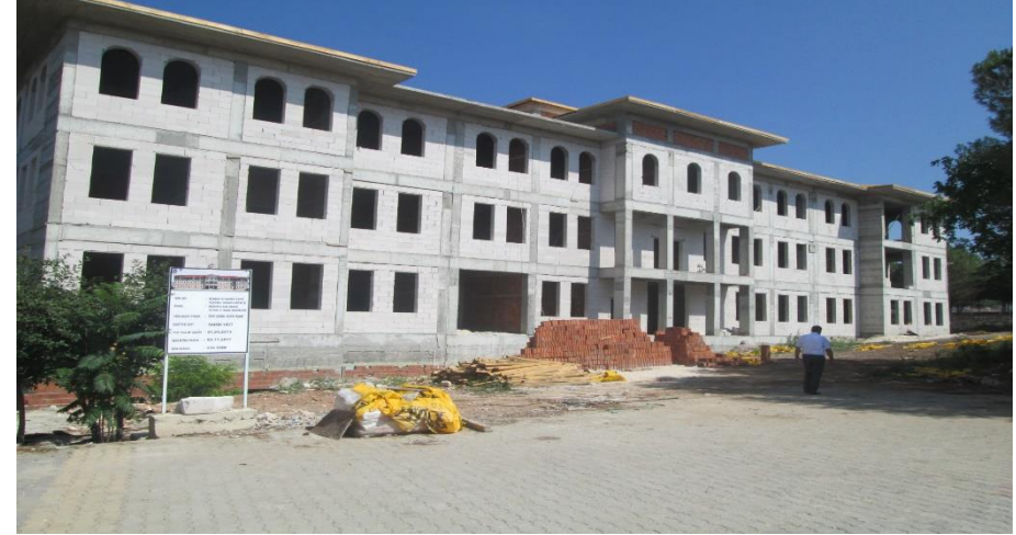
ÇAVDIR HÜKÜMET KONAĞI İNŞAAT FOTOĞRAFI
